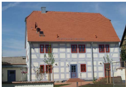
Mehrfamilienhaus mit Wasser-Sole-Wärmepumpe
