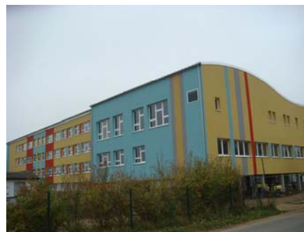
Schulgebäude mit Wasser-Sole-Wärmepumpe
